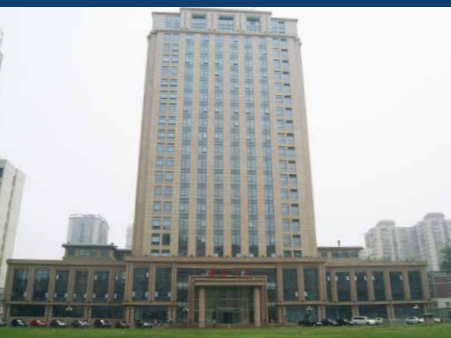
北京公司迁进嘉泰国际大厦
